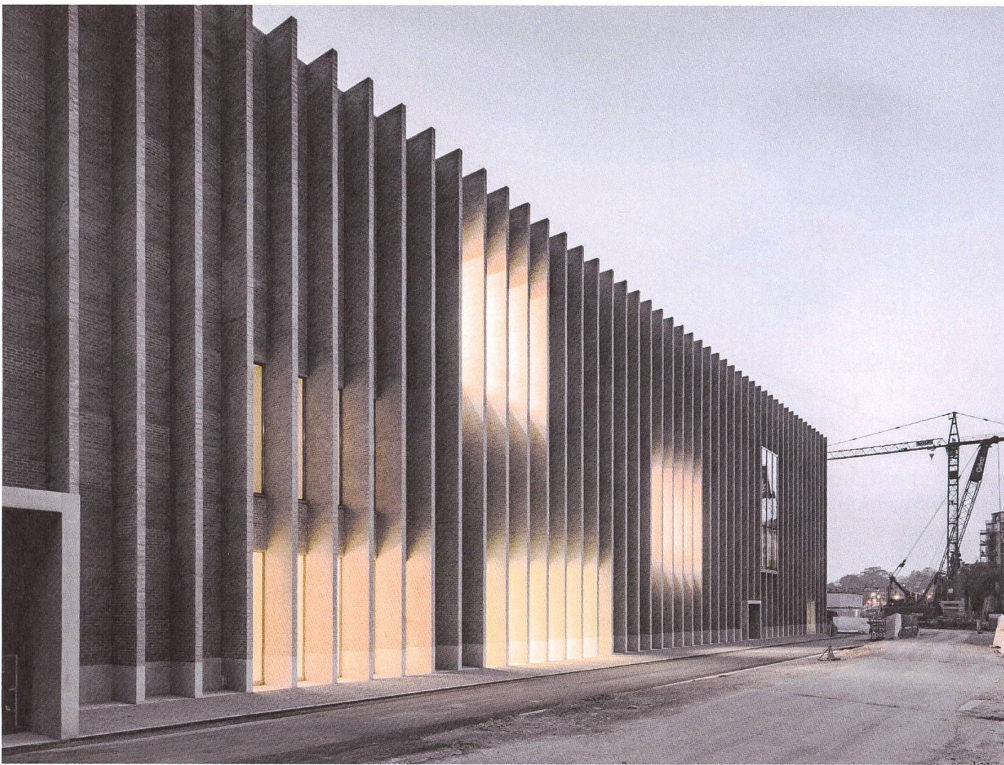
Einzelne Öffnungen durchbrechen die aus grauem Backstein gemauerte Lamellenfassade.
