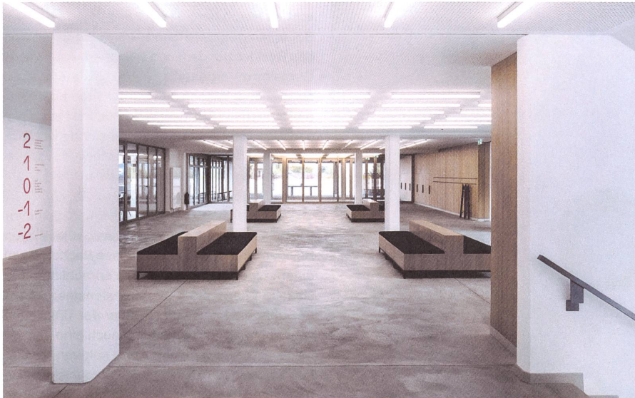
Neue Durchsichten und alte Transparenz im Hergiswiler Schulhaus Grossmatt: Die Architekten haben bestehende Qualitäten wieder freigelegt.
