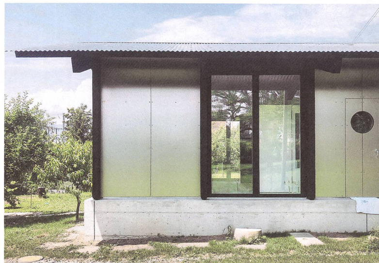
Der Erweiterungsbau steht auf einem Betonsockel.
