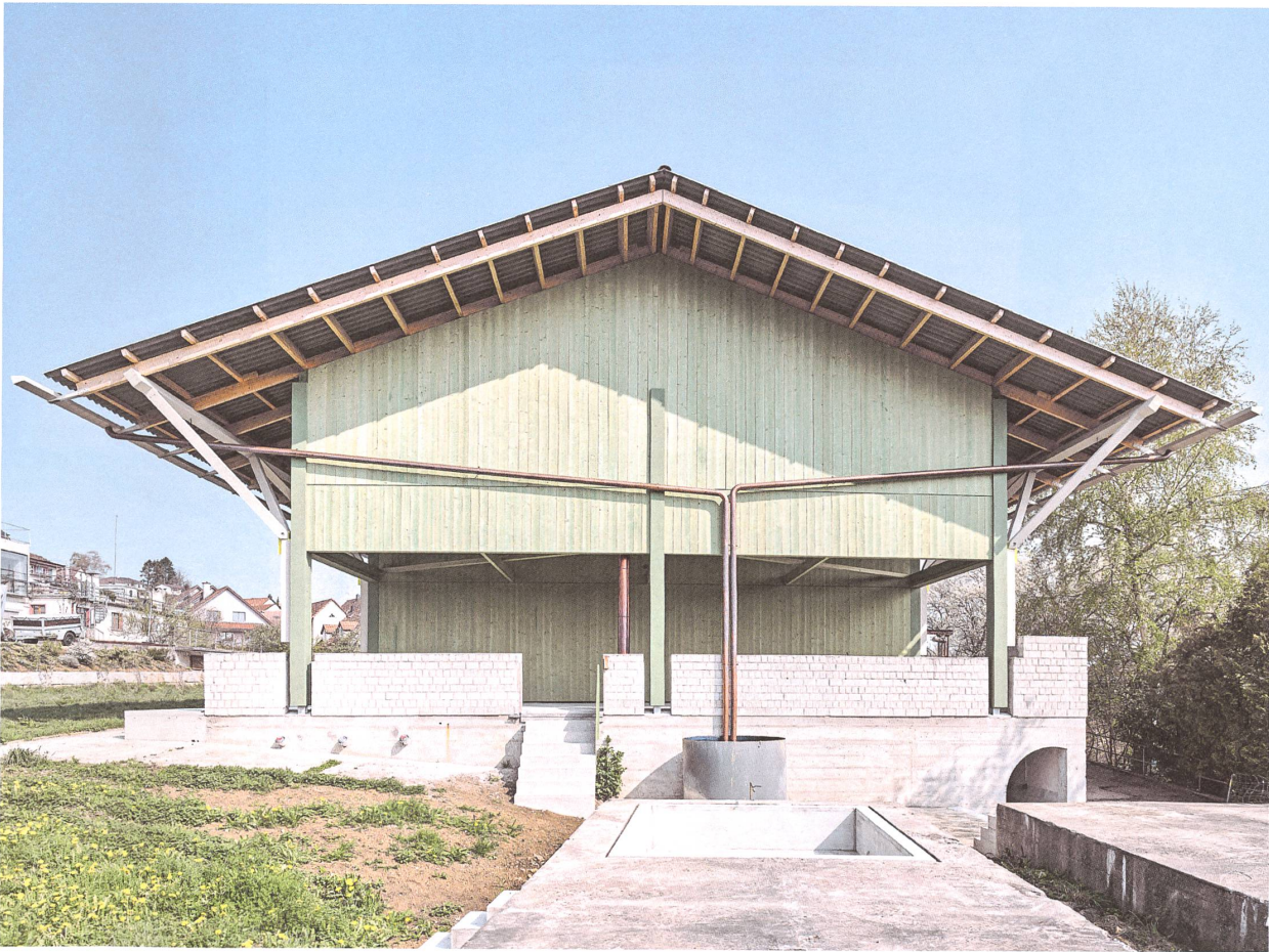
Im letzten Abschnitt des Atelierwohnhauses liegt ein Gemeinschaftsraum mit Freiluftküche, die Fundamentreste davor dienen als Sonnenterrassen.
