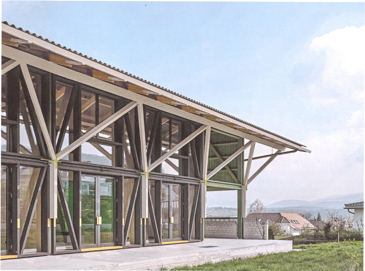
Der Holzbau in Nuglar im solothurnischen Schwarzbubenland setzt auf dem Kellergeschoss eines ehemaligen Weinlagers auf.
