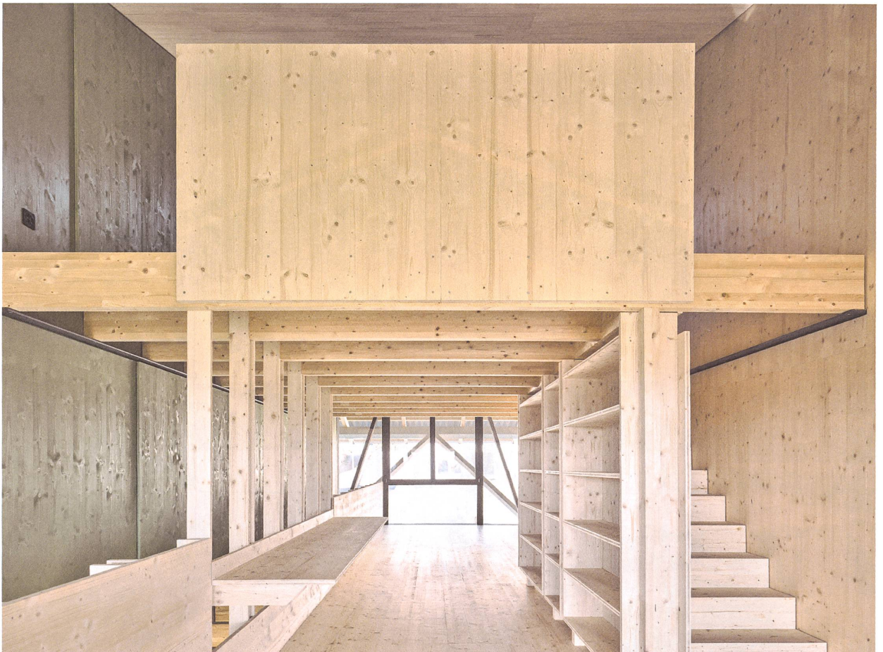
Dank dem modularen Bausystem können die Bewohner selbst entscheiden, wo sie Geschosse einziehen möchten.
