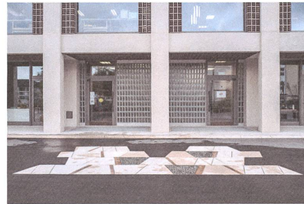
«Fussabtreter» aus Betonplatten, geschmückt mit gusseisernen Reliefs, markieren die Eingänge von Kindergarten, Primarschule und Bibliothek.
