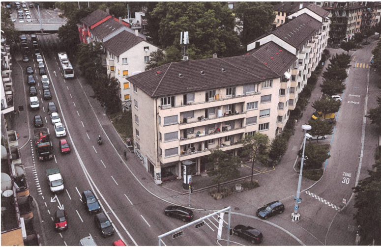
Die Häuserzeile am Rosengarten wird für die Portalanlage abgerissen werden.
