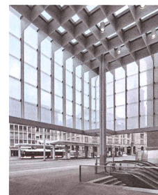
Umbau Bahnhof St. Gallen Giuliani Hönger und Hager Partner
