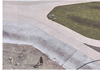
Max-Kämpf-Platz, Basel Bau- und Verkehrsdepartement Basel-Stadt
