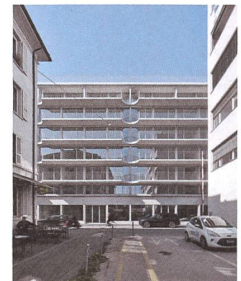
Umbau Geschäftshaus Neustadtstrasse, Luzern Rohrer Sigrist Architekten
