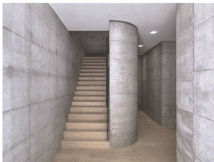
Der Beton im Treppenhaus fängt die Zufahrt zum Nachbarhaus ab.
