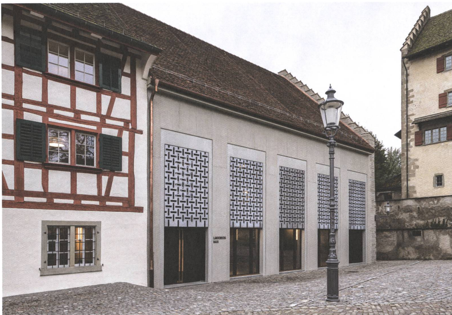
Das Landenberghaus in Greifensee: Betonmauer mit von Falltoren inspirierten Aluminium-Elementen, abgetreppte Giebelfassade, roter Riegelbau.
