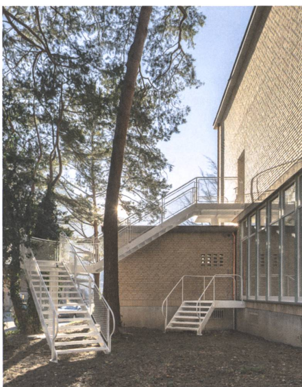
Auffallend neu sind nur die Fluchttreppen.
