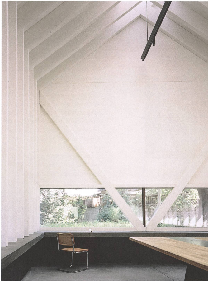
Dunkler Sockel, heller Raum: Kräftige Holzträger gliedern den Bau in Rancate.
