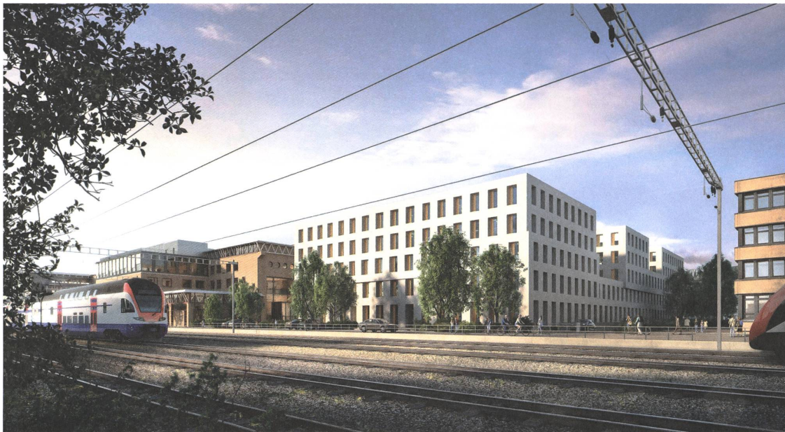
Der Quantensprung: «2226 Schlieren» entsteht gerade auf dem Areal der ehemaligen NZZ-Druckerei. Mit 30 000 Quadratmetern Bürofläche.
