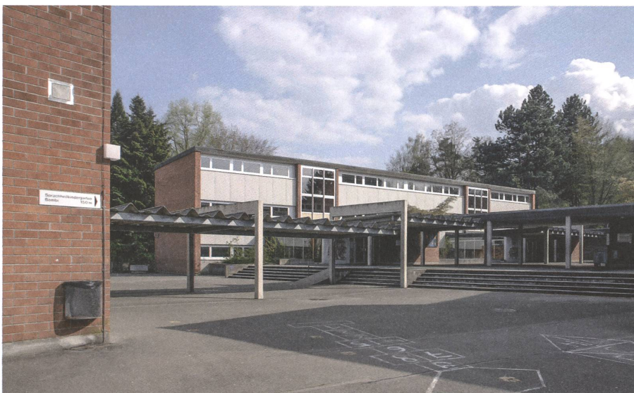
Pausenhof mit überdeckten Verbindungswegen.
