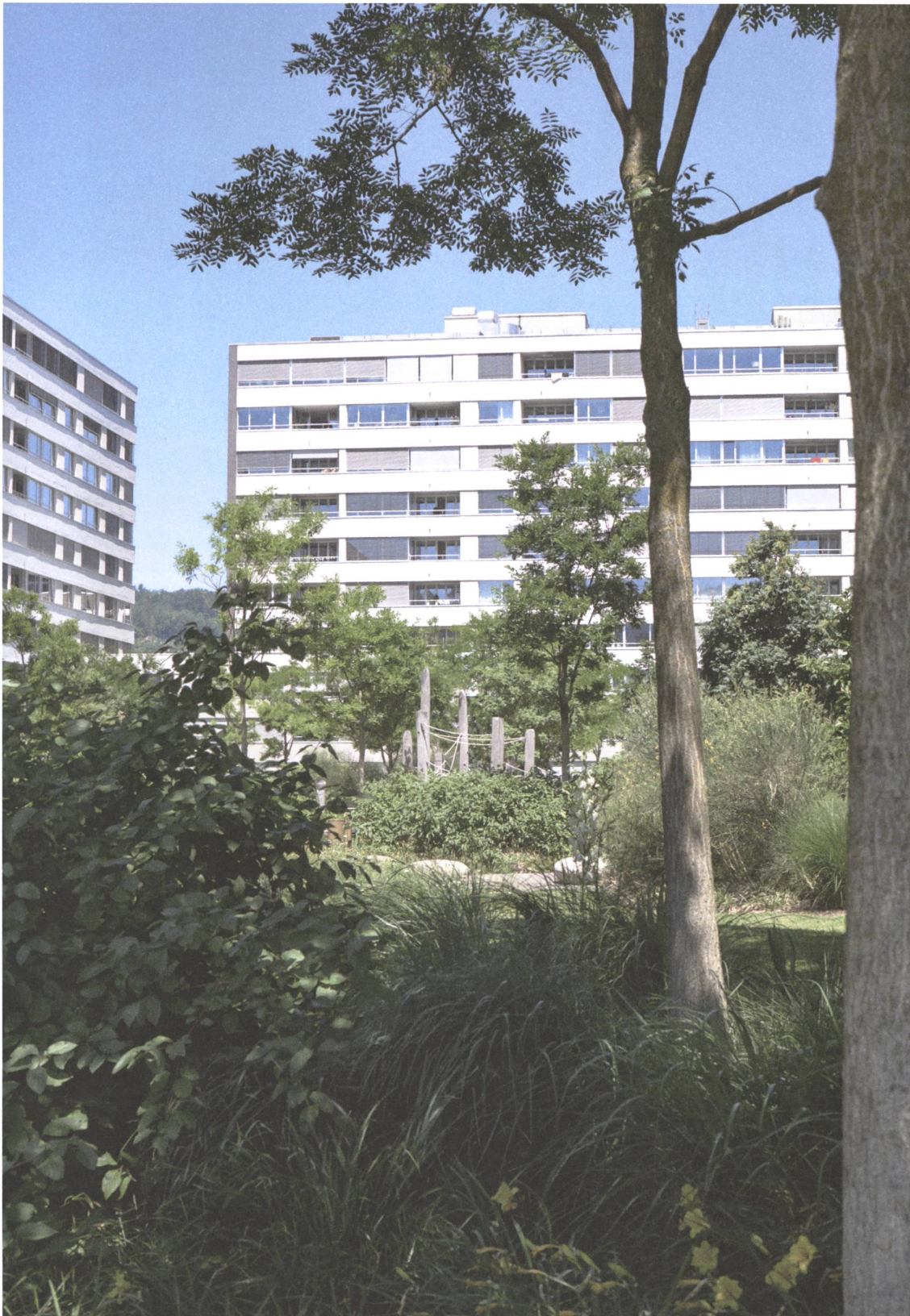
Maaghof, 2014 Zürich Bauherrschaft: Swiss Life, Zürich; SPS Immobilien, Olten Landschaftsarchitektur: Krebs und Herde (Projekt von Rotzler Krebs Partner), Winterthur Begrünung: begrünter Innenhof (8710 m 2 ) auf Tiefgarage Erstellungskosten (Gesamtprojekt): Fr.1,9 Mio.
