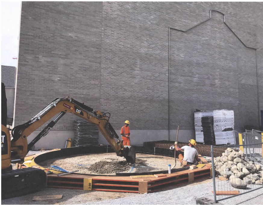
Die Kreisel wurden am Bauplatz aus Ortbeton gegossen. Fotos: Inch Furniture
