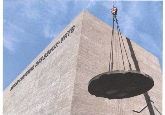
Drei Punkte auf der Unterseite stabilisieren das Möbel.
