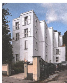
Umbau Chemin Guillaume- Ritter, Freiburg Aviolat Chaperon Escobar
