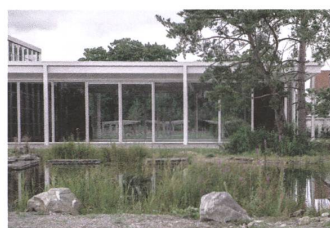
Sanierung und Erweiterung Schulanlage Auen, Frauenfeld TG Jessenvollenweider
