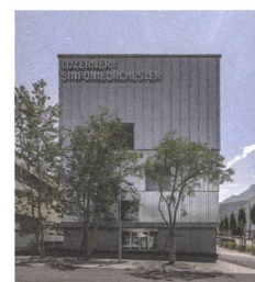
Probenhaus Luzerner Sinfonieorchester, Kriens LU Enzmann Fischer und Büro Konstrukt
