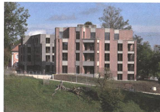
Wohnüberbauung Bahnhaldenstrasse, Zürich-Seebach Sergison Bates
