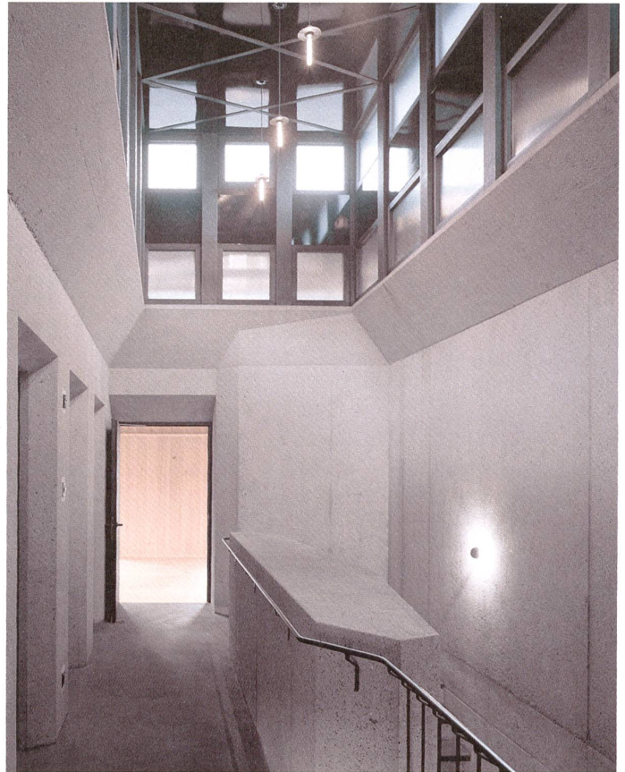
Polygonales Zentrum: Der sandgestrahlte Betonkern ist eine eigene Welt.
