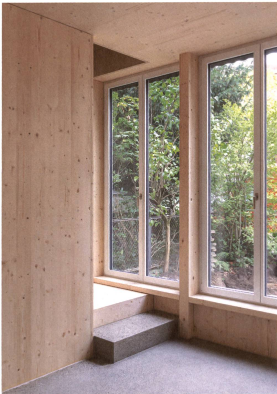
Eingepasst: Zementboden und Holzbau greifen präzise ineinander.
