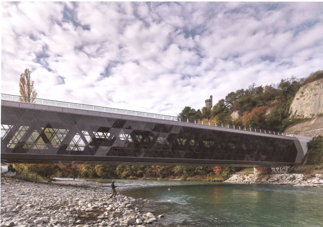
In einer verglasten Brücke überquert die CEVA die Arve.
