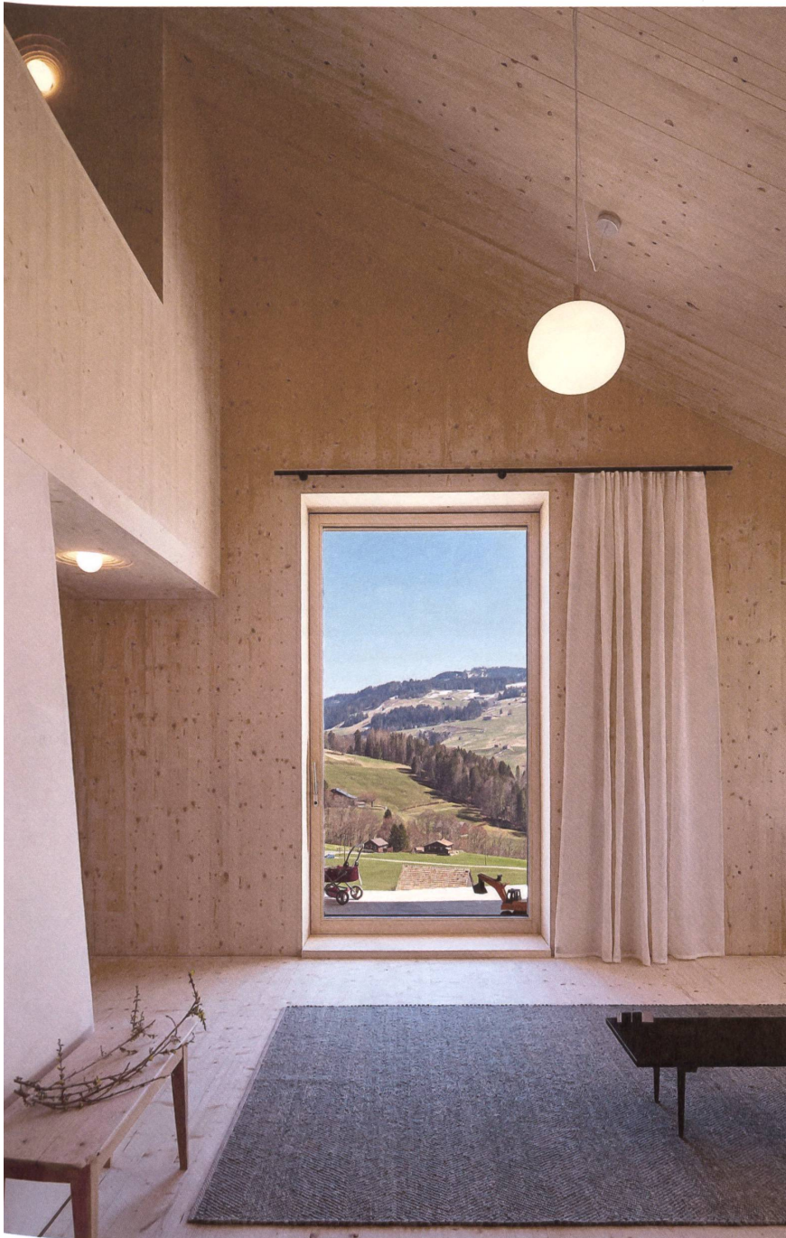
Die Vollholzkonstruktion des Hauses in Unterwasser besteht aus verdübelten Brettern.
