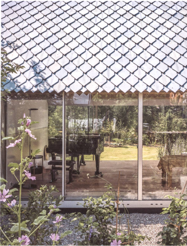
Für die Fassade eines Gartenpavillons der Architekten Georg und Lorenz Bachmann entwarfen SVNMM Acrylgips-Fliesen in 21 Blautönen. Foto: Lukas Maurer
