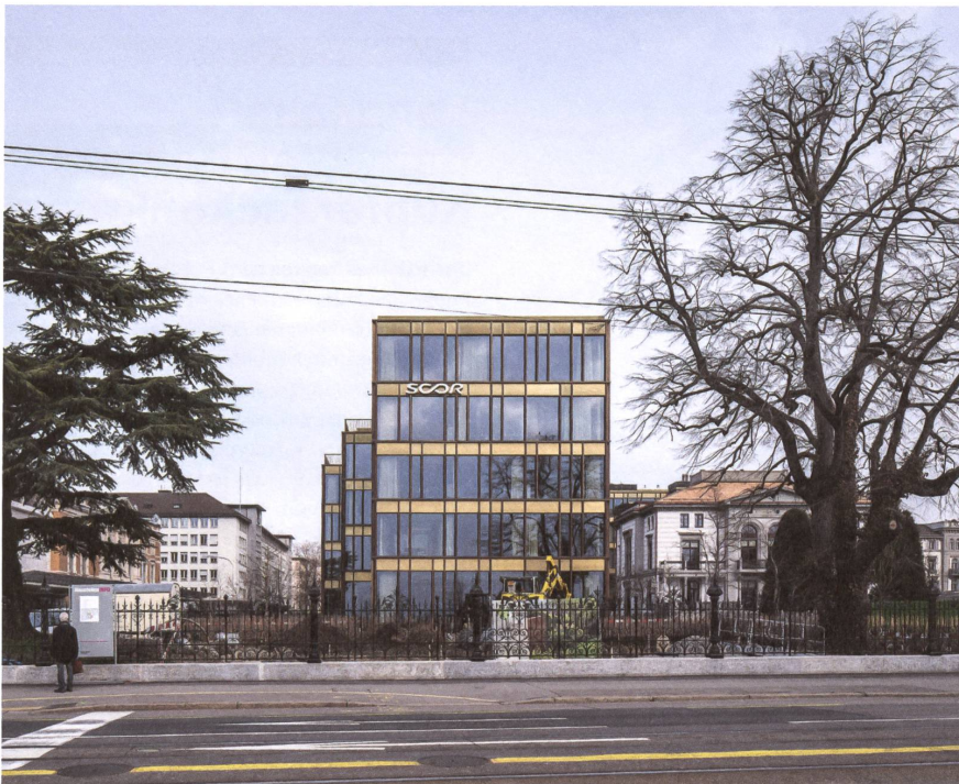
Der Neubau am General-Guisan-Quai in Zürich steht von der Strasse zurückgesetzt im Park der Villa Rosau.
