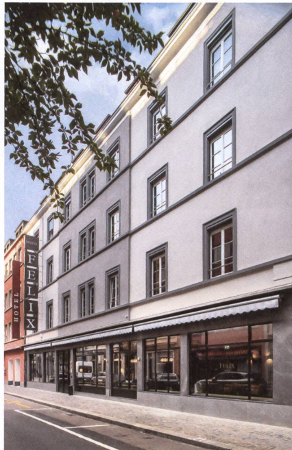
Die Fassade entspricht nun wieder dem Urzustand.
