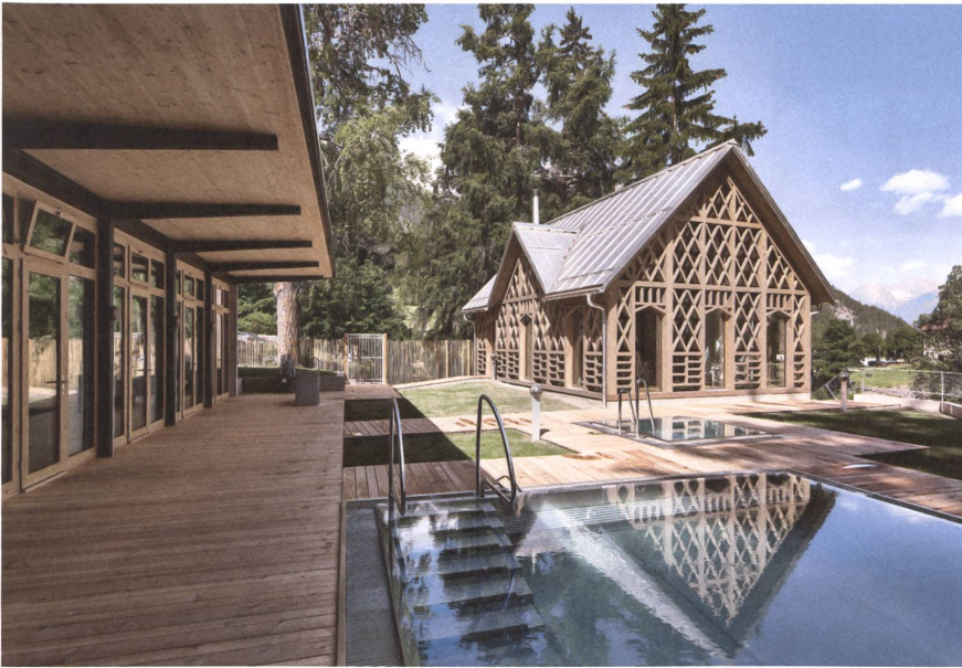
Umkleide- und weitere Räume links, Ruheraum hinter Fachwerk, davor Heiss- und Kaltbecken.
