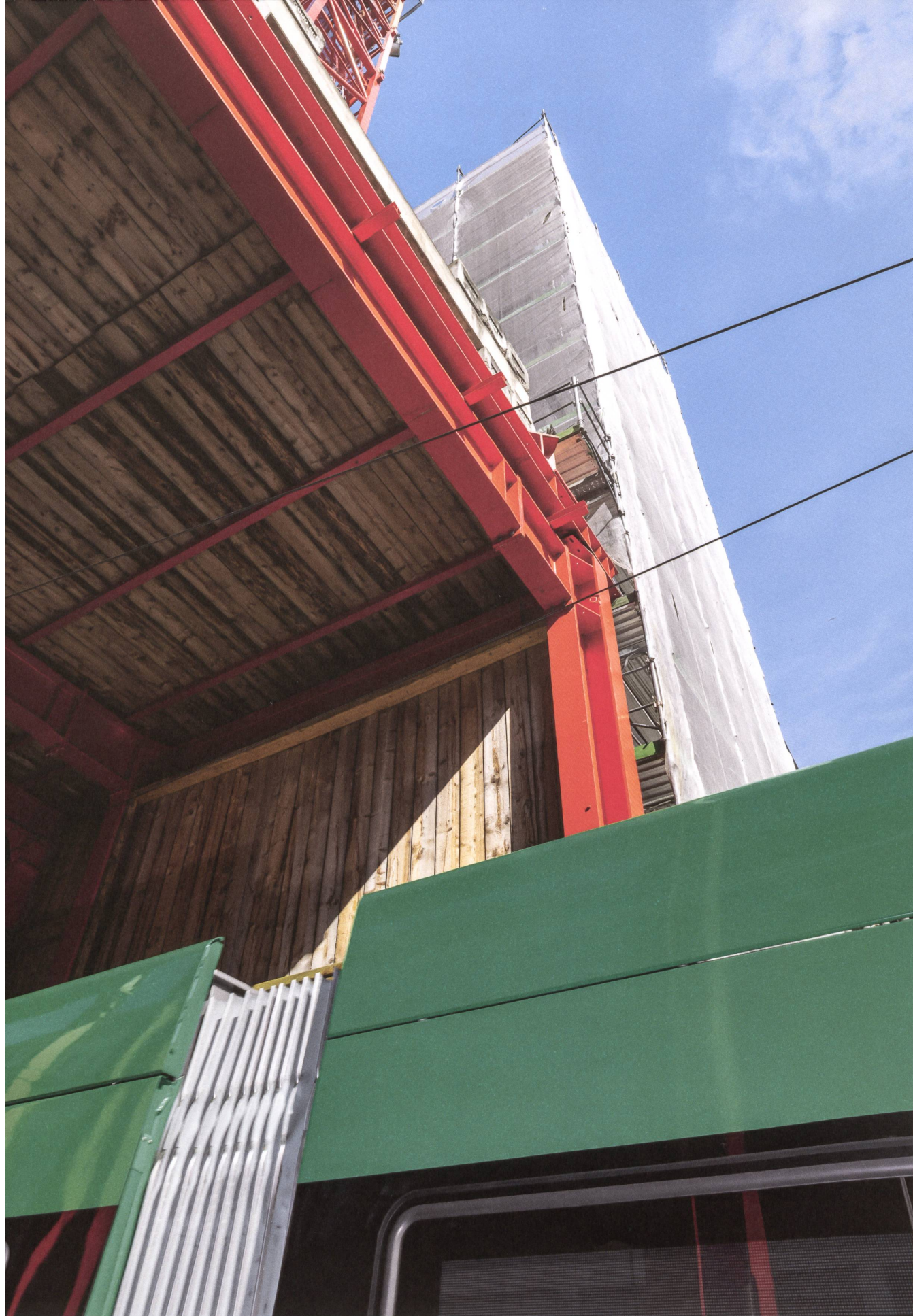
Basel: Neubau für das Amt für Umwelt und Energie.
