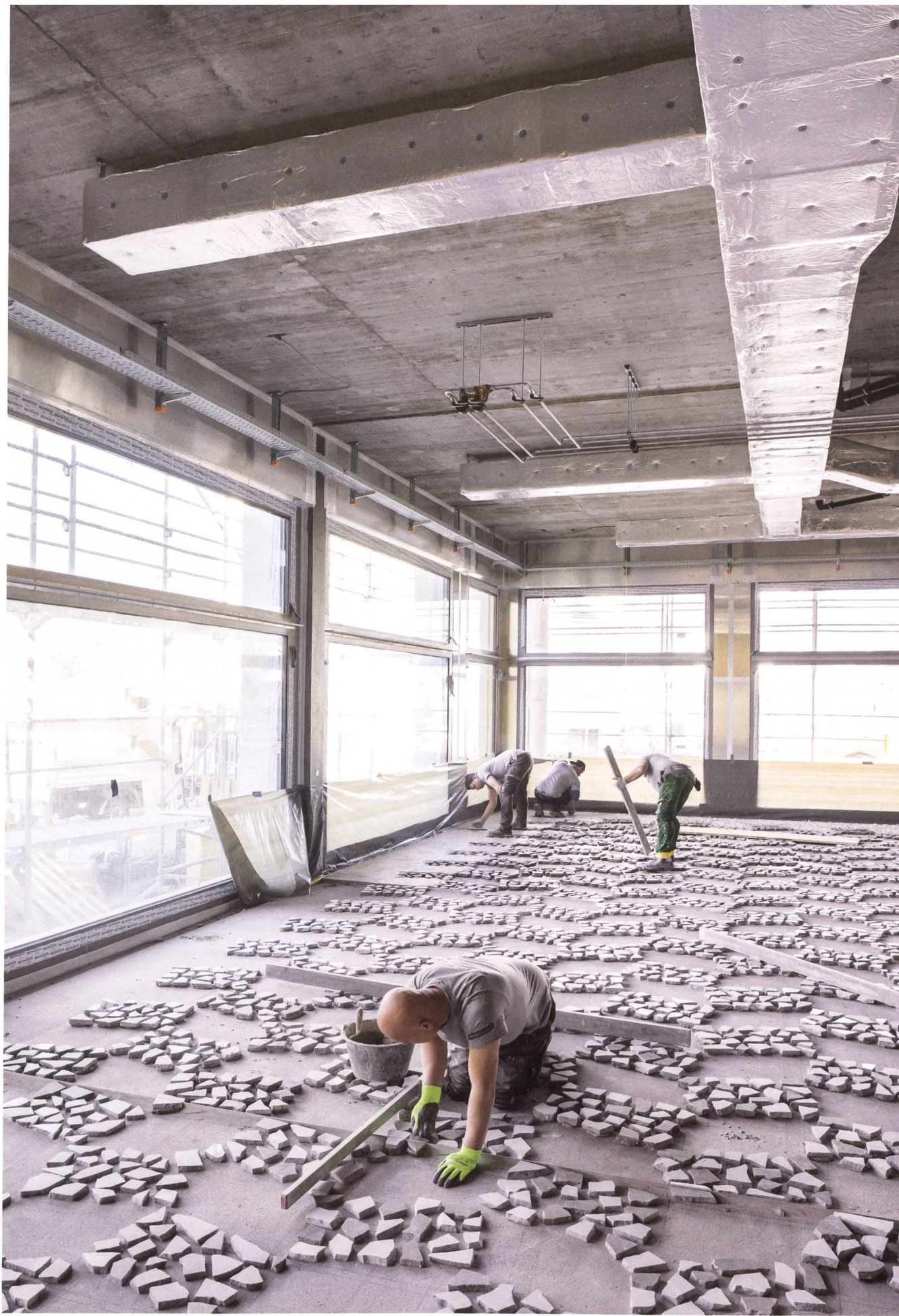
Altdorf: Neubau für das Kantonsspital Uri.
