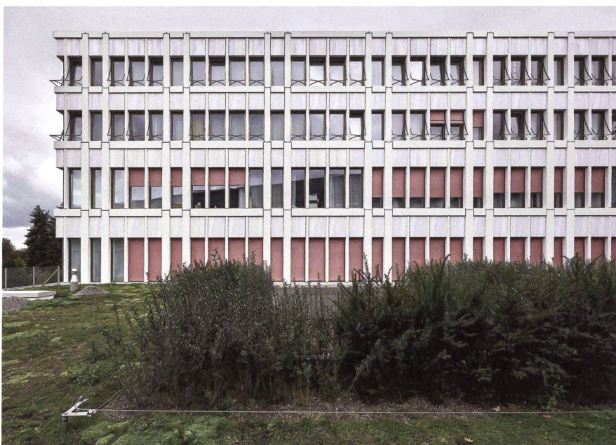
Der Neubau beherbergt vorübergehend die Frauenklinik. Später wird das Haus zum Organ- und Tumorzentrum.
