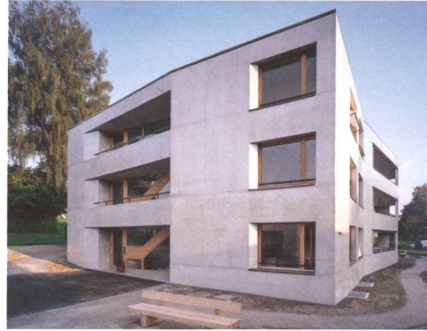
Wohnheim für Menschen mit Behinderungen, Reinach BL, 2005 Architektur: Neff Neumann Architekten, Zürich Leistungen b + p: Projektmanagement
