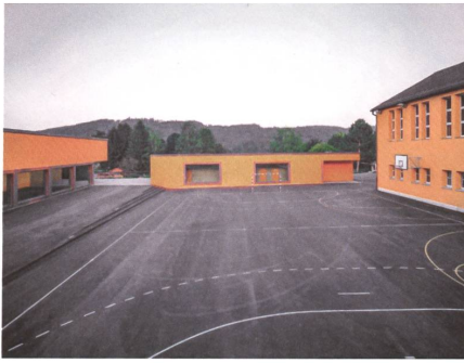
Schulsporthalle, Grafstal ZH, 2005 Architektur: Giuliani Hönger, Zürich Leistungen b + p: Baumanagement und Bauleitung, Kosten- und Projektmanagement
