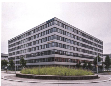
Büro- und Produktionsgebäude Siemens, Zug, 2018 Architektur: Burckhardt + Partner, Zürich Leistungen b + p: Kosten- und Terminmanagement, Phasen Wettbewerb und Vorprojekt
