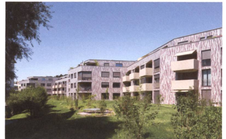
Wohnüberbauung Muniwies, Weiningen ZH, 2016 Architektur: Ken Architekten, Zürich Leistungen b + p: Wettbewerbsbeurteilung Wirtschaftlichkeit Neubau
