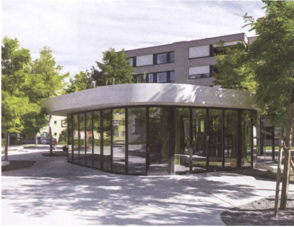
Wohnüberbauung Katzenbach II, Zürich, 2010 Architektur: Zita Cotti Architekten, Zürich Leistungen b+p: Baumanagement und Bauleitung, Kosten- und Projektmanagement
