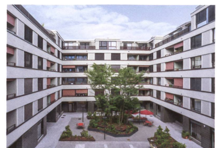
Alterswohnungen Erikastrasse, Zürich, 2019 Architektur: Zita Cotti Architekten, Zürich Leistungen b + p: Wettbewerbsprüfung, Wirtschaftlichkeit
