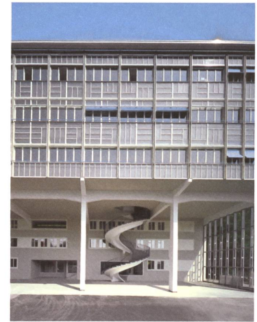
Berufsbildungszentrum Bruggerstrasse, Baden AG, 2006 Architektur: Burkard Meyer Architekten, Baden Leistungen b + p: örtliche Bauleitung
