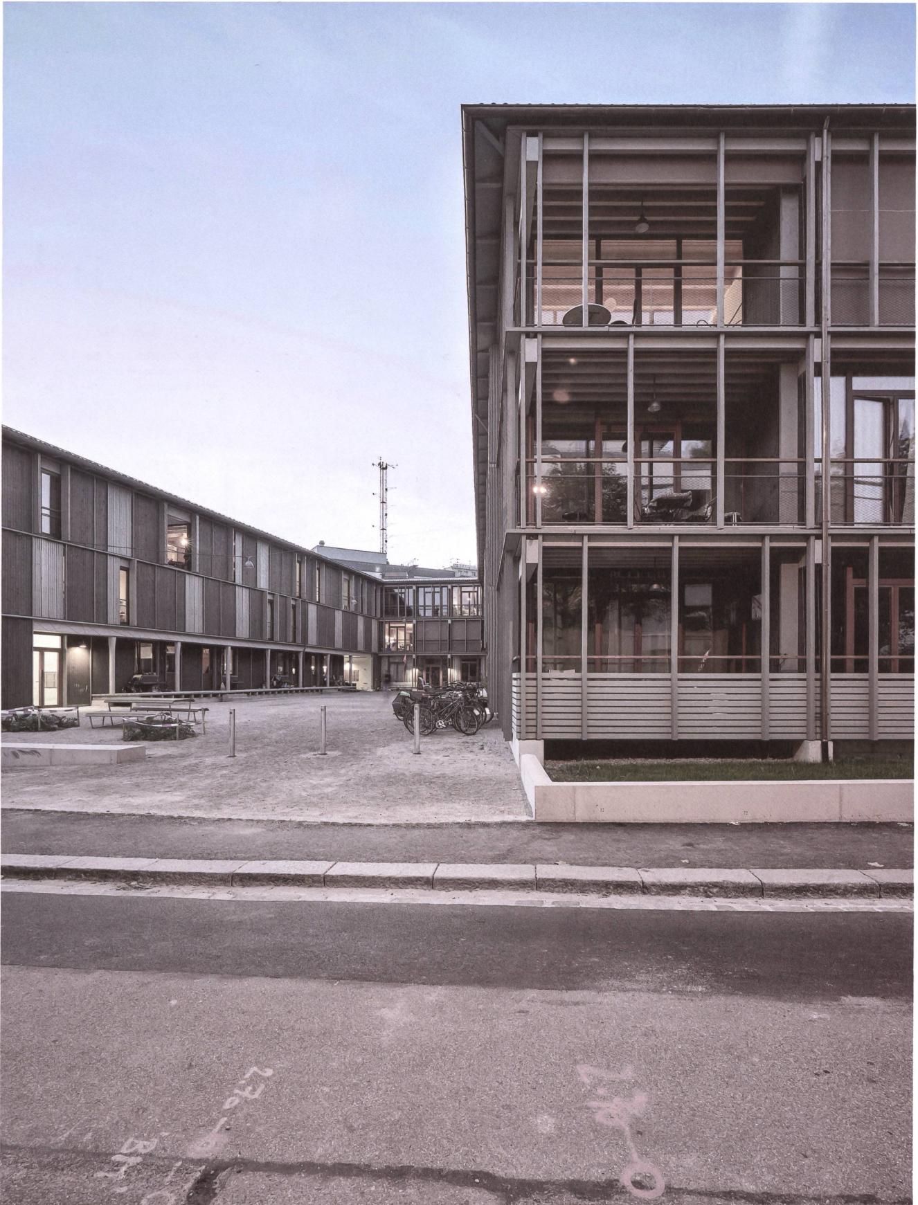
Ein geklester Platz führt von der Malengasse in die Tiefe und erschliesst alle 39 Wohnungen.
