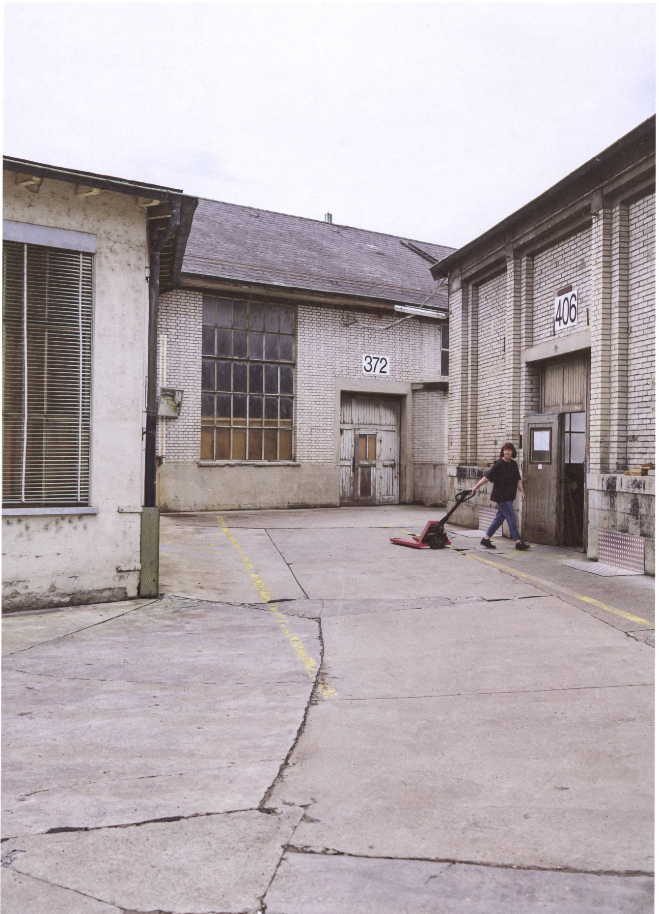
Gut die Hälfte des Wydenneck-Areals in Dornach mietet bis 2024 noch Swissmetal. Bis 2040 will die Hrag hier über 1000 Wohnungen und Arbeitsplätze realisieren.
