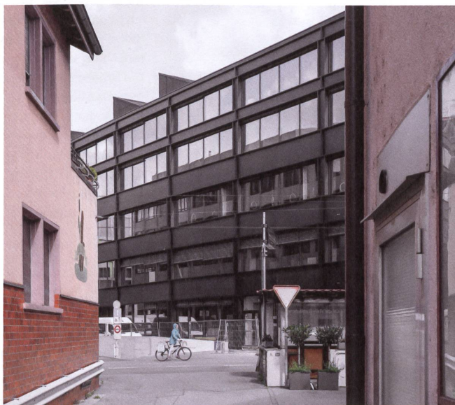
Elegante und zurückhaltende Fassade in Mattschwarz.
