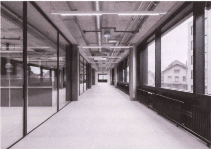
Die Gebäudetechnik wird offen geführt.
