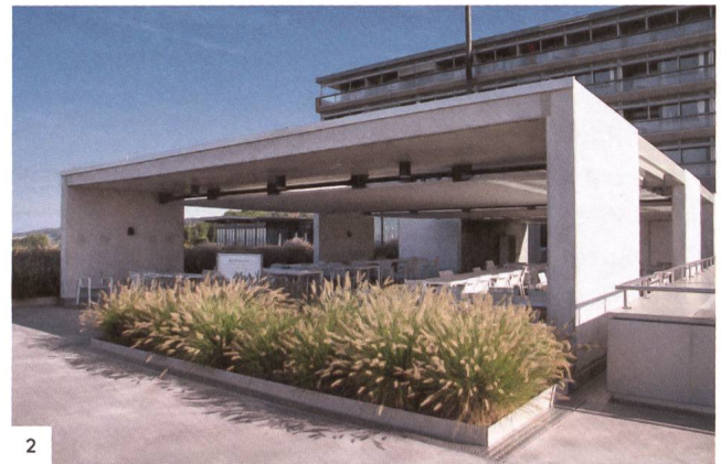
2 In einer Rehaklinik in Bellikon schützt eine speziell gefertigte Vordachkonstruktion die geparkte Gegenzuganlage. Je sechs Einheiten beschatten zwei miteinander verbundene Betonterrassen. Wind-, Sonnen- und Regenwächter steuern das Ein- und Ausfahren des Systems. Fotos: Melanie Keller, Marketing MHZ Schweiz
