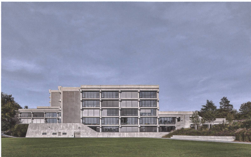
Die Kantonsschule Hardwald wurde zwischen 1969 und 1973 oberhalb des Oltnar Bahnhofs aus dem Wald geschnitten.
