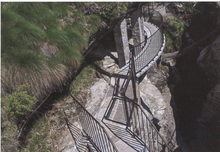
Pfeiler stützen die überhängende Felspartie, Konsolen tragen den Weg.
