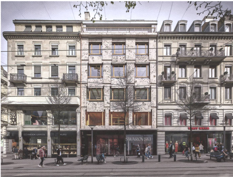
Nach oben verjüngend: die Fenster in der Tuffsteinfassade der Bahnhofstrasse 78 in Zürich.
