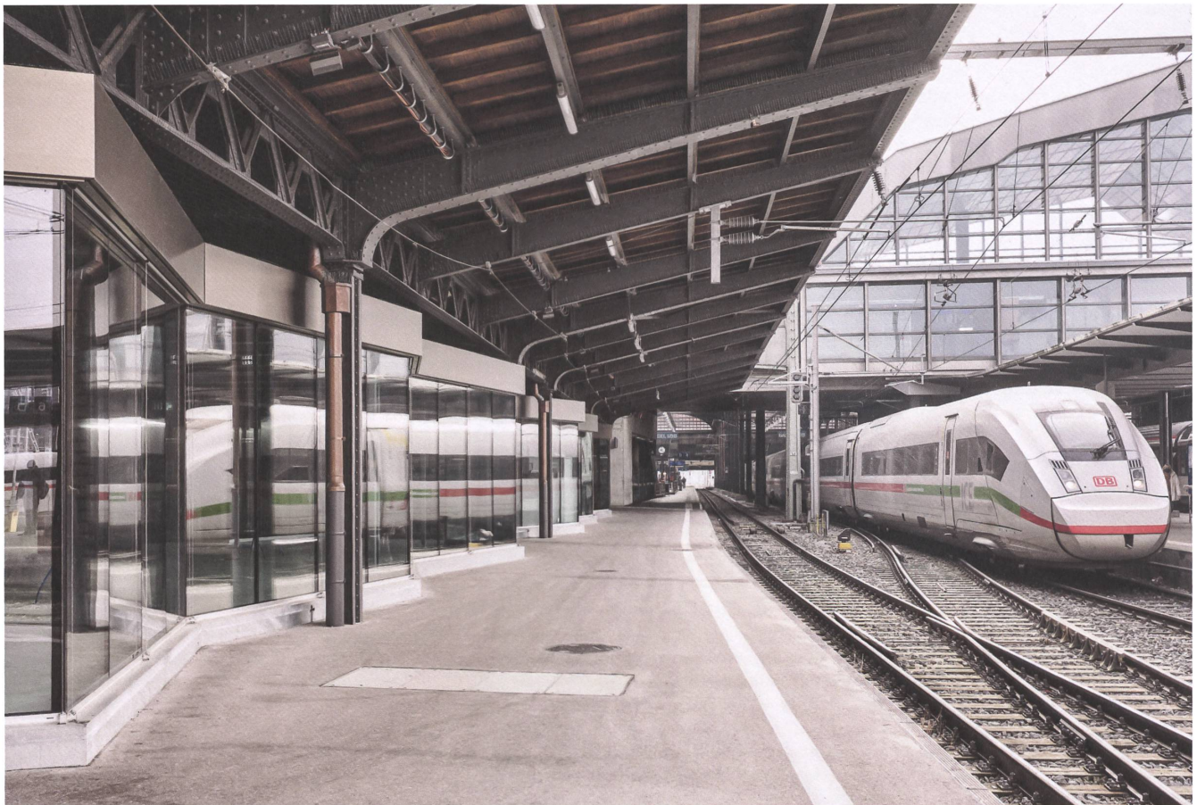
Neben den Gleisen setzt ein gläserner Vorbau einen zeitgenössischen Akzent. | Près des voies, une avancée en verre donne un accent contemporain.
