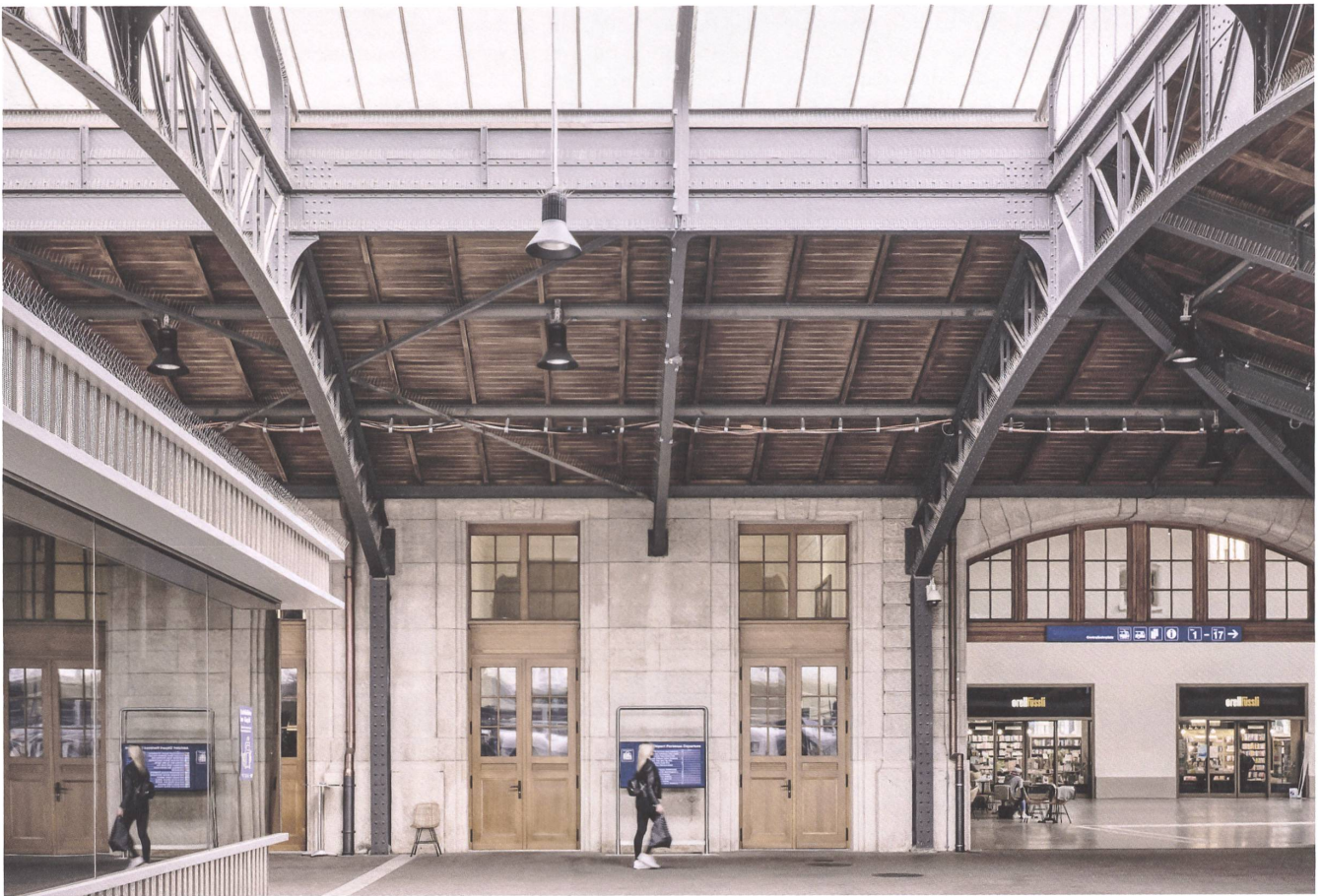
Der historische Bestand wurde sorgfältig saniert. | La substance historique a été soigneusement rénovée.
