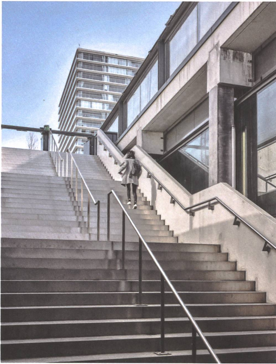
La montée depuis la nouvelle gare de Chêne-Bourg vers la tour Opale. | Aufgang aus dem neuen Bahnhof Chêne-Bourg zur Tour Opale. Photo | Foto: Rolf Siegenthaler
