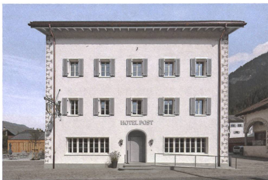
Das Hotel Post in Andeer mit der wiederhergestellten Schauffassade.
