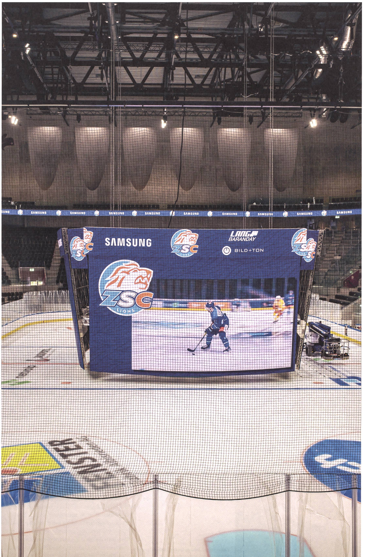
Die Stahlkonstruktion des Stadionsdachs trägt viel Technik, unter anderem einen «LED-Cube», der vierseitig Livebilder, Werbung und den Spielstand anzeigt.
