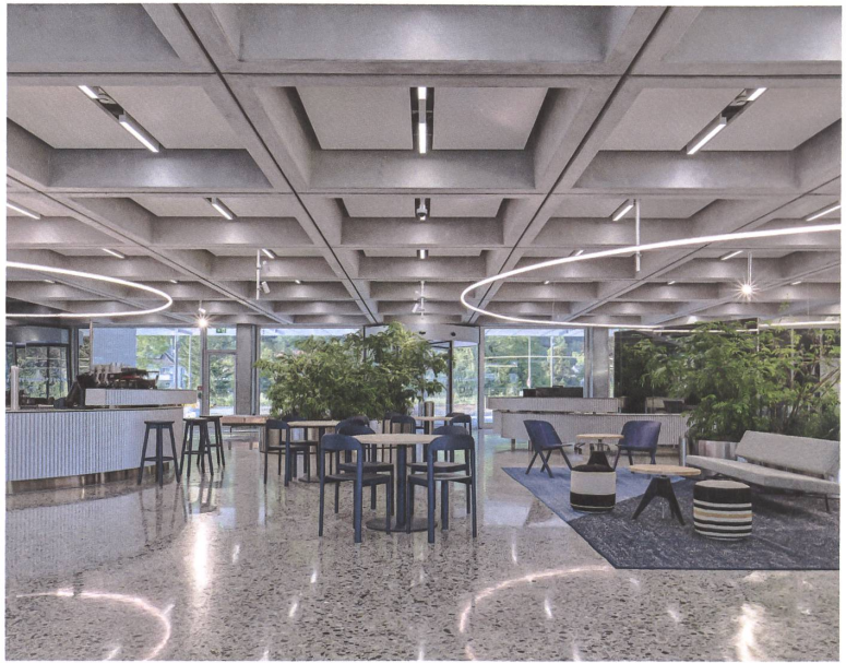
Auch das Erdgeschoss bleibt weitgehend stützenfrei.
