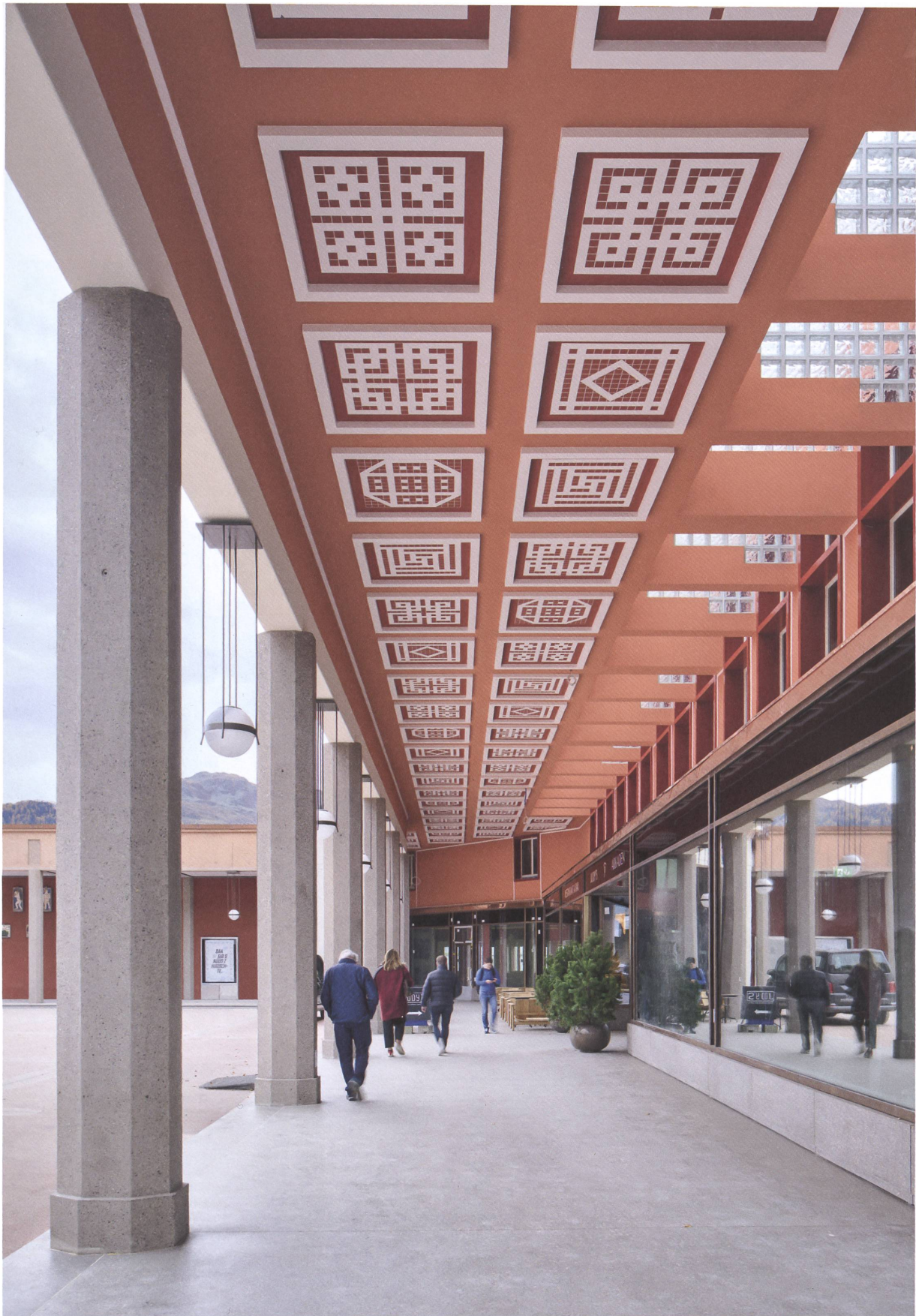
Mit grossem Können von den Architekten Jüngling und Hagmann rekonstruiert: der neue Flügel der Arkade für die Kantonalbank. Fotos S. 26/27: Ralph Feiner
