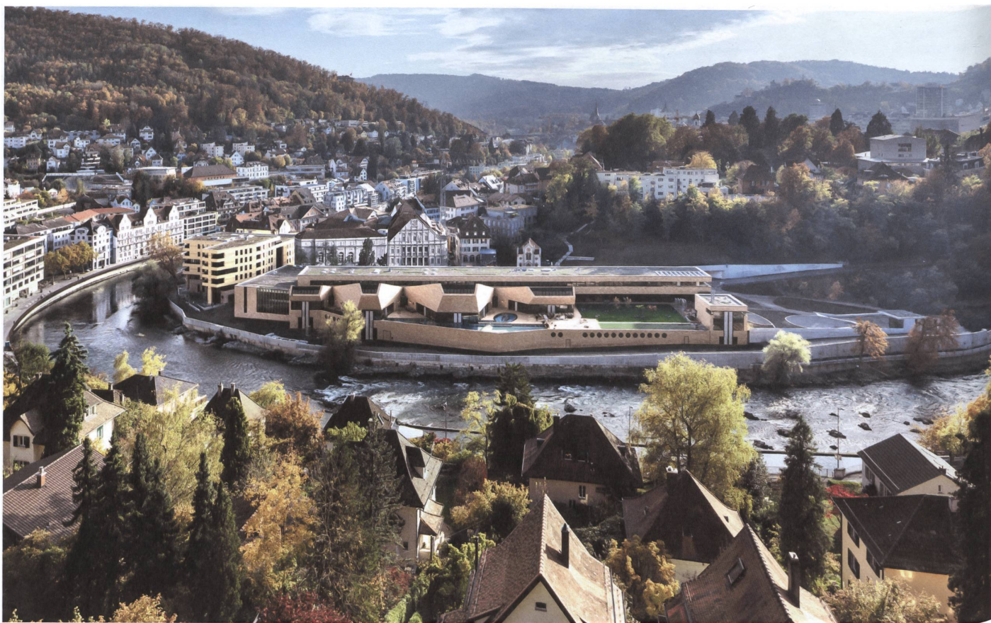
Blick aufs Thermalbad von Ennetbaden aus: Das gelbe Gebäude links ist die «Residenz 47», die Tiefgarage des Badekomplexes reicht bis unter den Park rechts.
