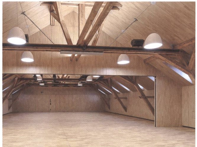
Die beiden Singsäle sind als hölzernes Futteral in die Dachkonstruktion integriert.
