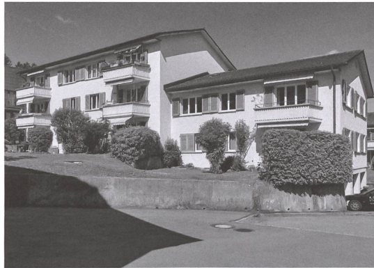
Eine der beiden Zeilenbauten von 1953.
