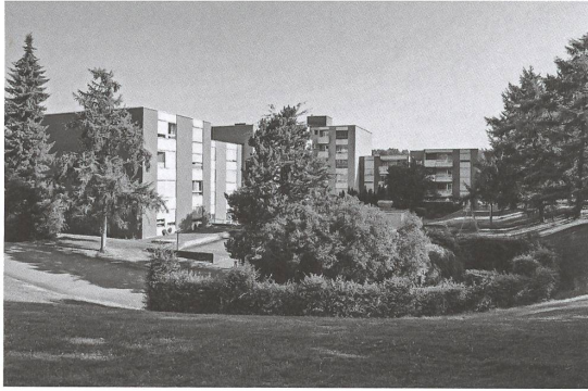
Die Siedlung vor der Sanierung.
