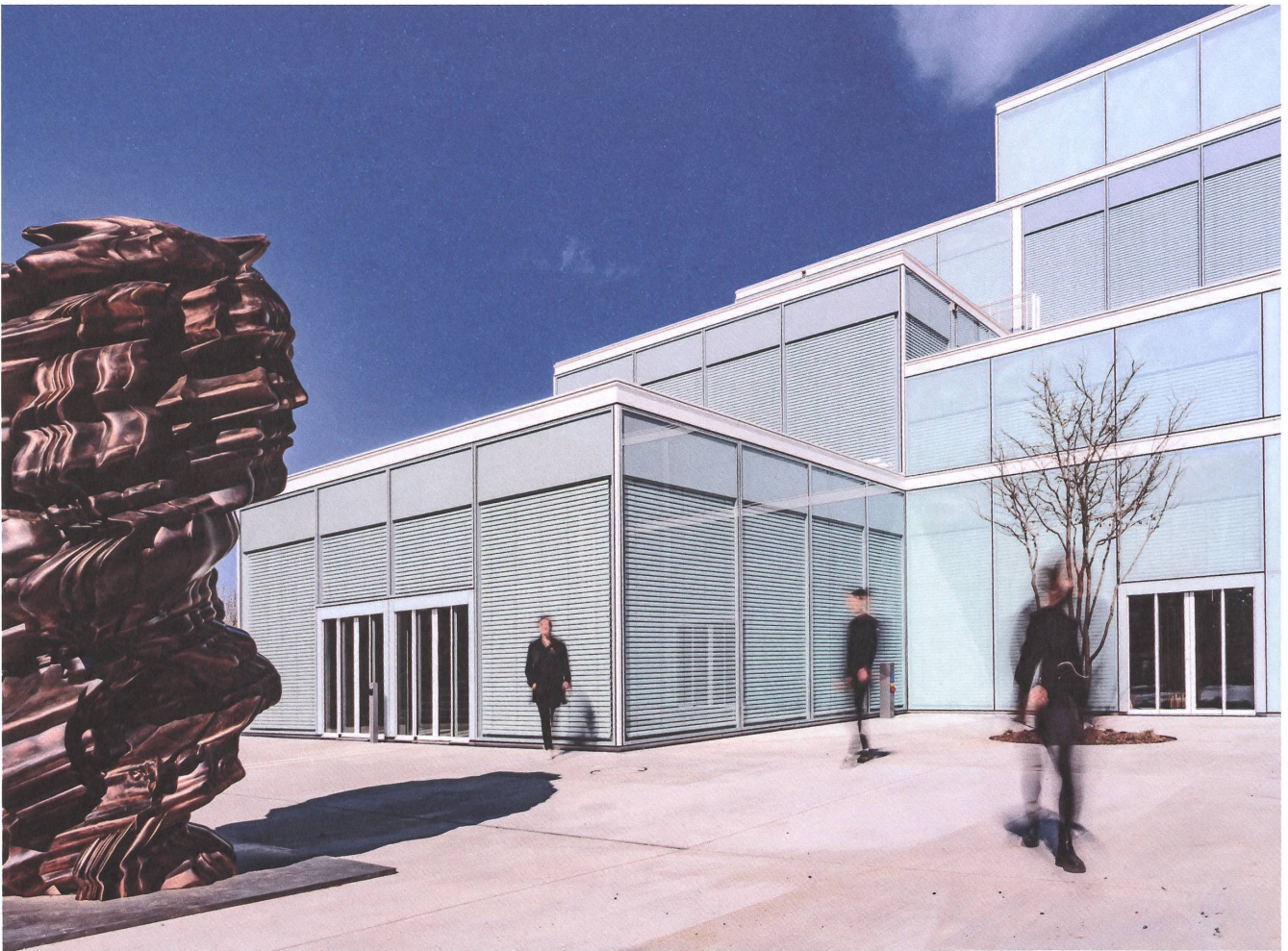
Wenn die Sonne scheint, verschliesst sich die transparente Fassade des Glashauses.
