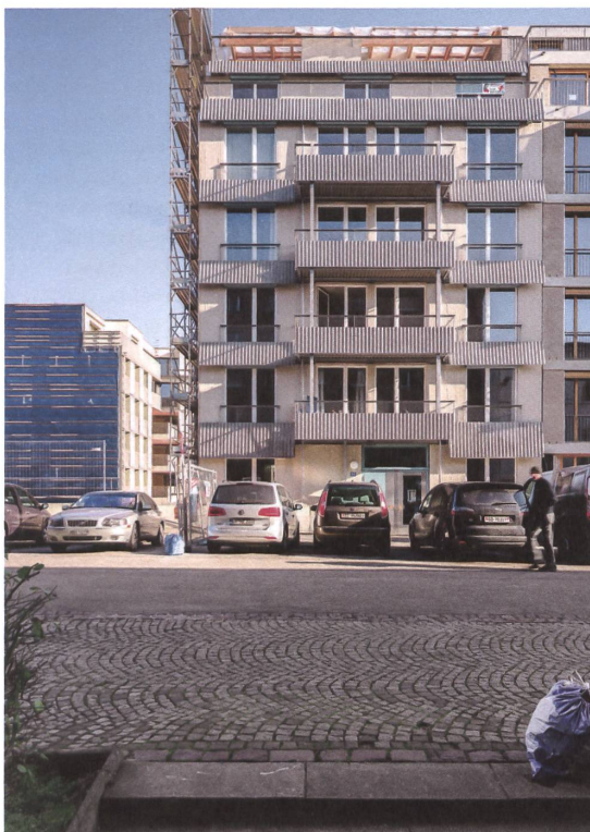
Die Eternitwellen an der Fassade schützen die Storen und prägen den Charakter des Hauses im neuen Basler Quartier Lysbüchel Süd.
