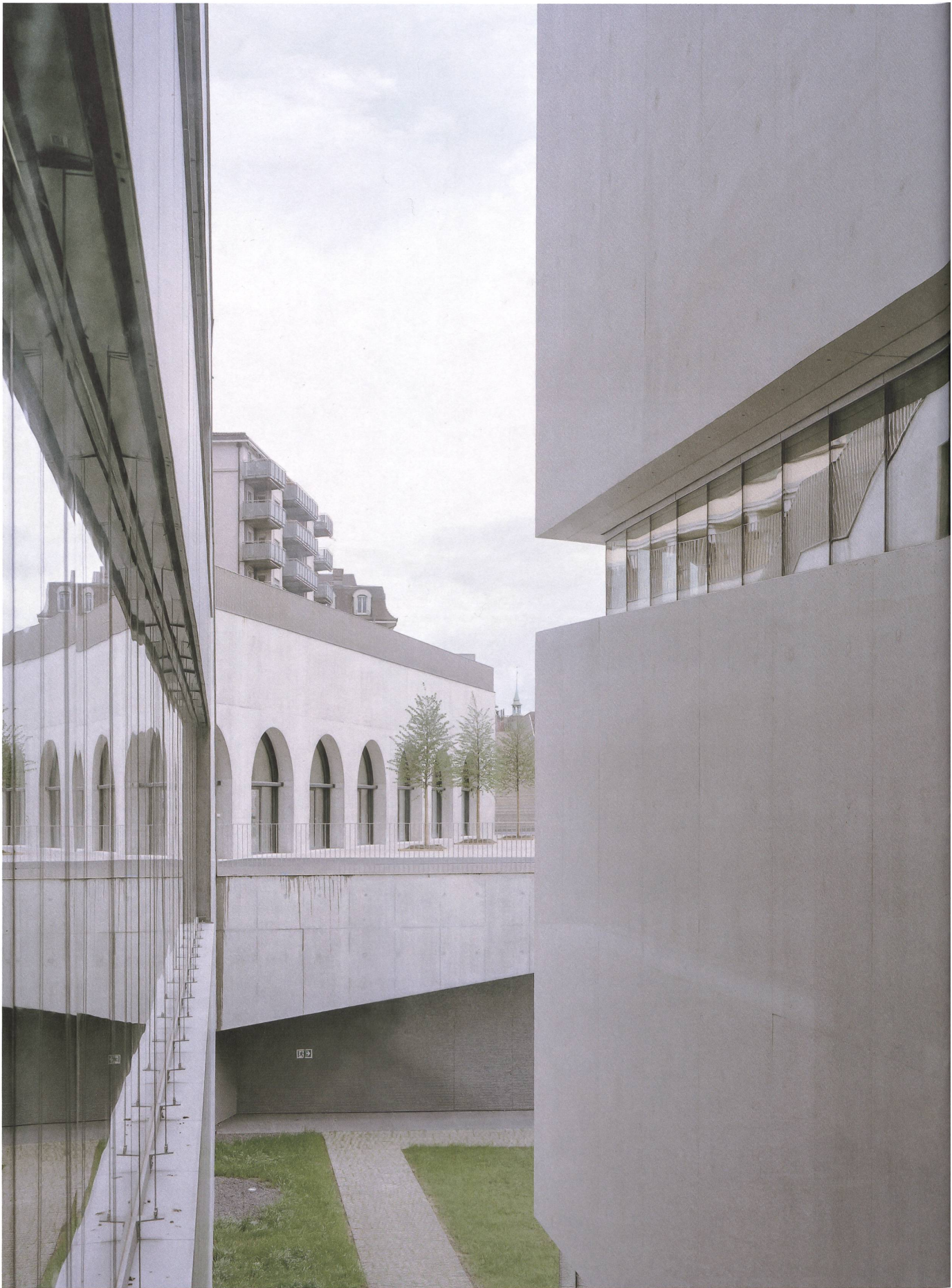
Hangseitig flankiert ein L-förmiger Glasbau den Museumskubus. Er mündet in einen abgesenkten Hof und schliesst an die Arkaden an.
