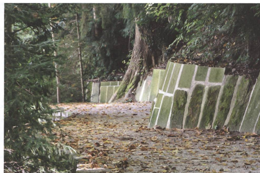
Mauern aus horizontal verlegten Sandsteinen stützen den Hang.
