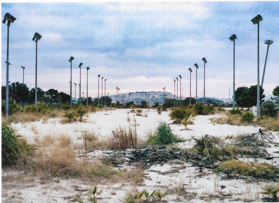
Bâti sur du sable: solitaires, les poteaux d'éclairage du centre d'entraînement de volley des JO d'été d'Athènes (2004) se détériorent avec la ville en toile de fond. Photo: Jamie McGregor Smith
