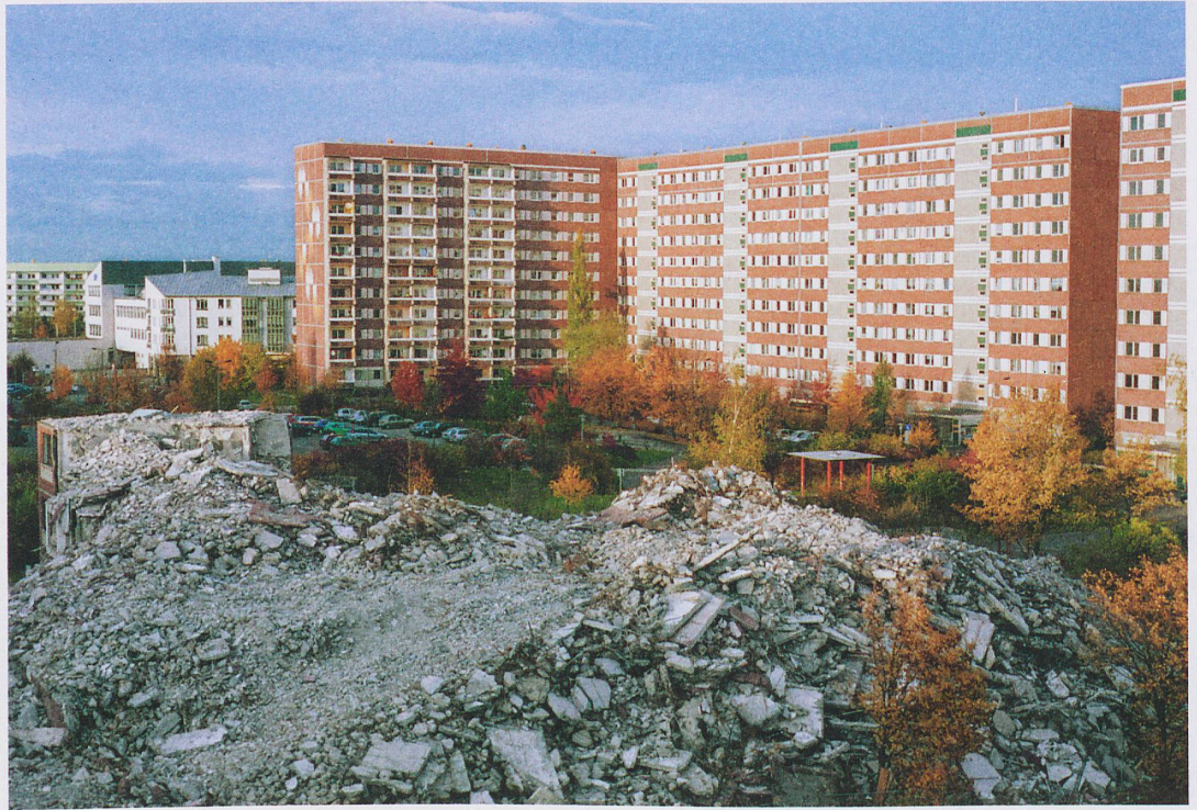
Die Trümmer sind die Reste eines Plattenbaus in Leipzig. Hier wurde gezielt in den Abbruch leer stehender Wohnbauten investiert.
