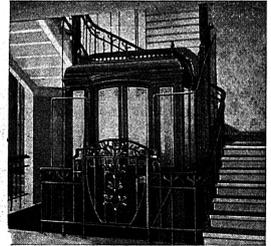
mit automatisch-elektrischer Druckknopfsteuerung
