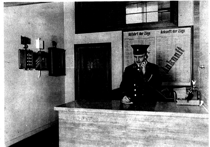
Lichtruf Tafel, Feuermelder für den Alarm der städtischen Feuerwehr, Empfangseinrichtung einer automatischen Feuermelderanlage und Hebellinienwähler für Haus- und Amtsverkehr mit angebaute Wählscheibe in der Portierloge eines Hotels
