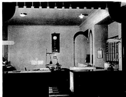
Rohrpoststation in der Halle eines Hotels
