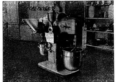
**Type U. H. 2** mit rostfreien Kesseln von 50 bzw. 20 Litern Fassung, **Type U. H. 1** mit Kesseln von 30, 45 u. 20 Litern, je mit eingebautem Elektromotor, autom. Schmiebung, mit je 4 Anschlusstellen für die aufsteck- und auswechselbaren Zusatzapparate, wie Fleischhackmaschine, Reib- u. Schneidemaschine, Passiermaschine, Brotschneidemaschine, Kaffee- u. Mühle, Maschine zum Schneideln von Fleisch, Lebern, Kutteln, etc.
