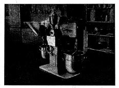
ype U. H. 2 mit rostfreien Kesseln von 50 bzw. 20 Litern Fassung, Type U. H 1 mit esseln von 30, 45 u. 20 Litern, je mit eingebautem Elektromotor, automat. Schmie-ung, mit je 4 Anschlusstellen für die aufsteck- und auswechselbarer Zusatzapparate, ie Fielschhackmaschine, Relb- u. Schneidemaschine, Passiermaschine, Brotschneide-aschine, Kaffermühle, Maschine zum Schneizeln von Fleisch, Lebern, Kutteln, etc.
