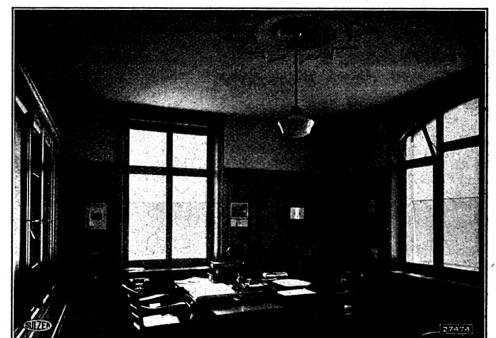
Privatbureau der Brauerei Hurlimann, Zürich, als Beispiel einer Asthischen, zugfreien Lüftung. Die stark gekühlte Luft wird durch eine Rosette über dem Betretungskörper eingeführt.
