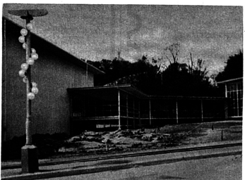
Gesamtansicht der Liegehallen
