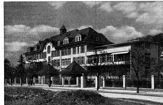
Auch das Städt. Krankenhaus Baden ist mit einer Albi-Anlage ausgerüstet
